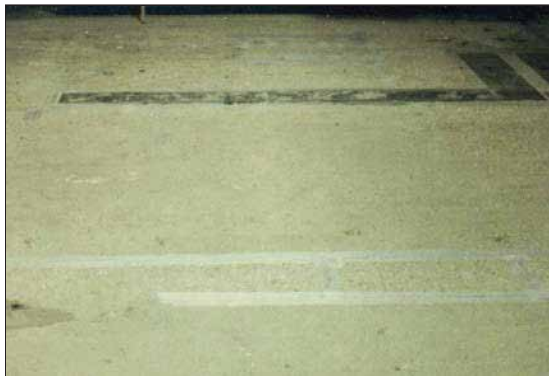
Agregado expuesto causó preocupación por la contaminación del papel y la seguridad del operador.
