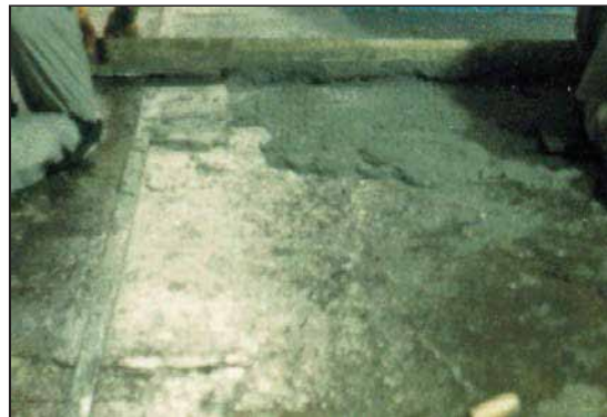
Regla aplicando el ARC 791 sobre el concreto imprimado.
