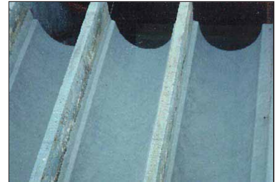
Los tres canales de la bombas reparados con ARC 791
