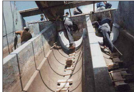
ARC 791 aplicado con la correcta preparación de superficie
