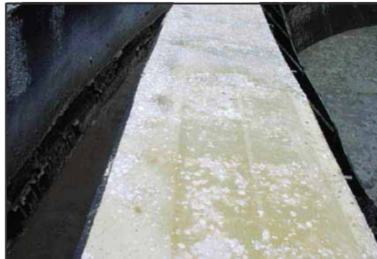
Superficie limpia y concreto dañado removido.
