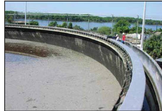
ARC 791 aplicado con la caja regla y acabado con llana o badilejo.
