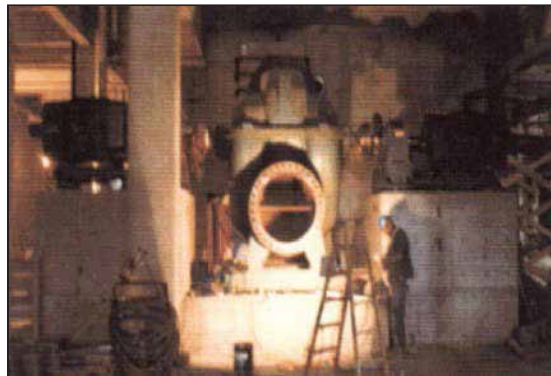
Desarmado del equipo antes de la reparación.
