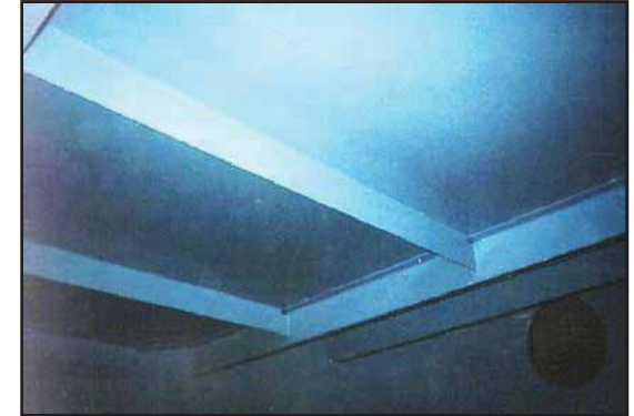
Techo y porción superior de los silos terminados.
