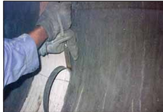
Removiendo el recubrimiento de caucho antes de la limpieza.
