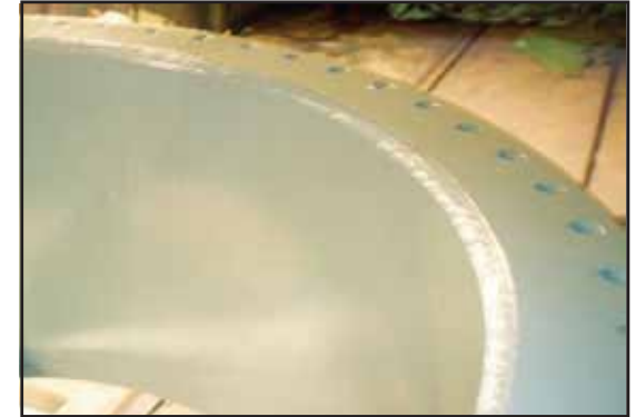
Nuevos tramos de tuberías granallados y recubiertos con ARC 855, a 900 \mu (35 mil).
