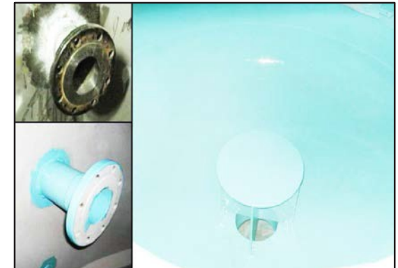
Aplicación final con ARC S2.
