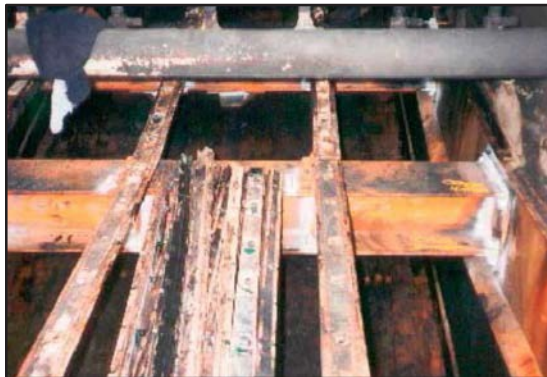
Tamiz de carbón dañada.
