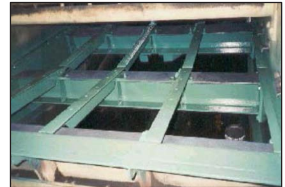
ARC BX2* aplicado sobre superficie superior de rieles.
