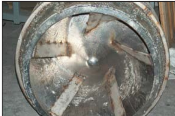
Reparación con soldadura de los álabes de los impulsores.
