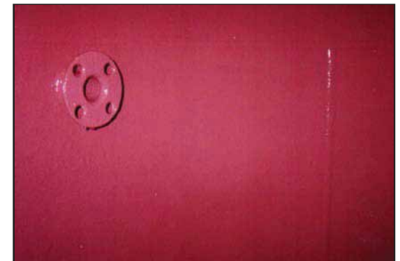
Después de una adecuada preparación de superficie, el ARC S4+ fue aplicado en un sistema de 2 capas.
