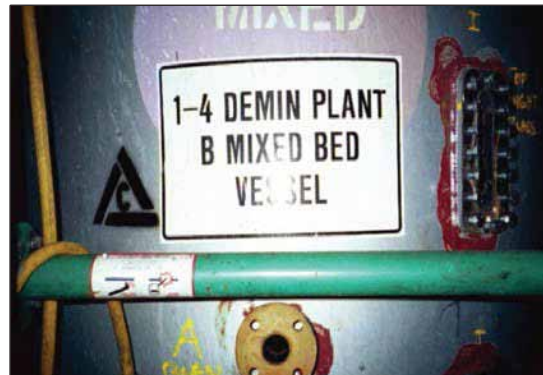
Vista externa del tanque.
