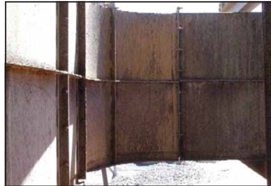
ARC S1PW aplicado a los ductos exteriores.
