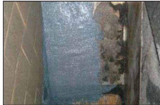
Aplicación de compuesto ARC MX5.
