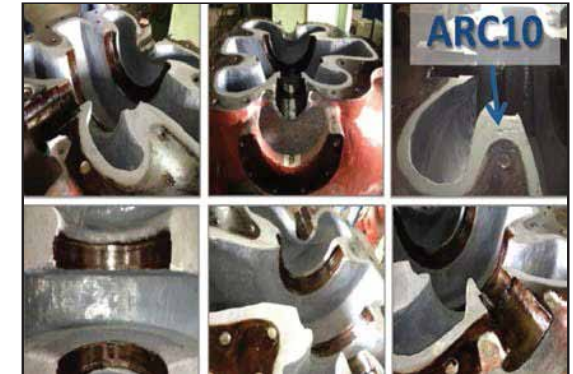
Reconstrucción y acabado final de la bomba.
