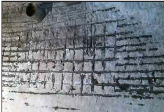
Pared del cajón después de remoción de losetas y granallado.
