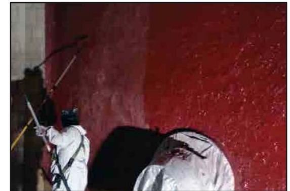
Aplicando capa de sellado con NVE VC .
