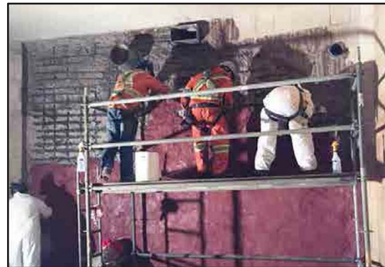
Aplicación del revestimiento ARC NVE .
