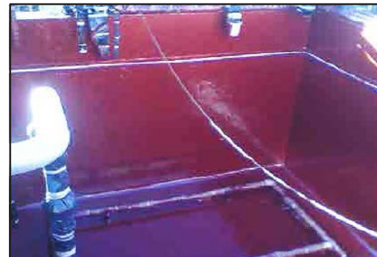
Aplicación finalizada con ARC CS4 .
