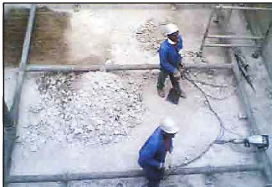
Preparación de superficie.
