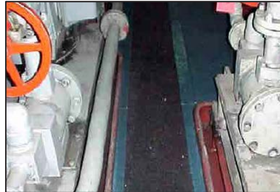
Áreas de alto tránsito revestidas con ARC 855N para evitar resbalamientos.
