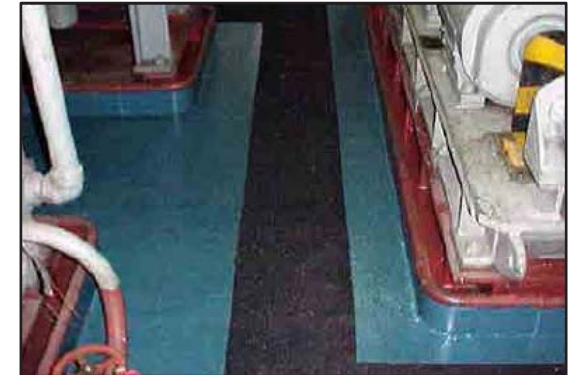
Franja para transitar con sistema anti deslizante antes de sellar.
