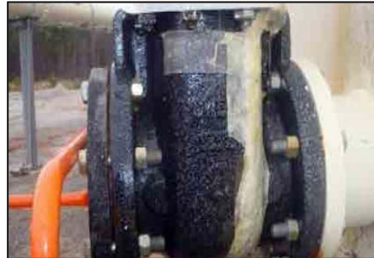
Malla de refuerzo siendo aplicada.
