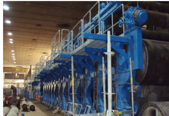
ARC S1 aplicado al a estructura durante renovación.
