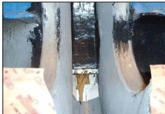
Bombas reconstruidas con ARC 858, MX2 y 855
