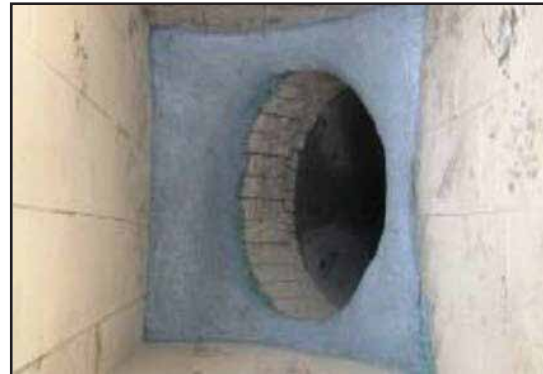
Instalación de ARC MX5.
