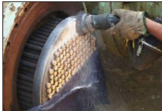
Preparación de superficie y protección de tubos.
