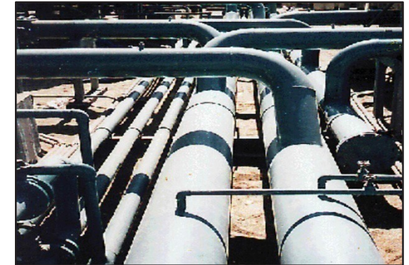
Sistema de tuberías completado, después de 10 años.
