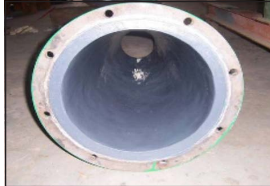
Cono de salida reparado.
