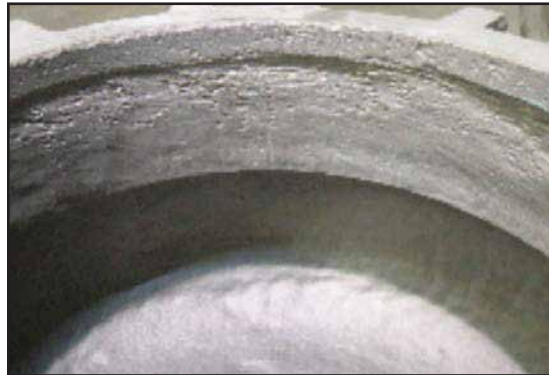
Carcasa en operación antes de recubrir.
