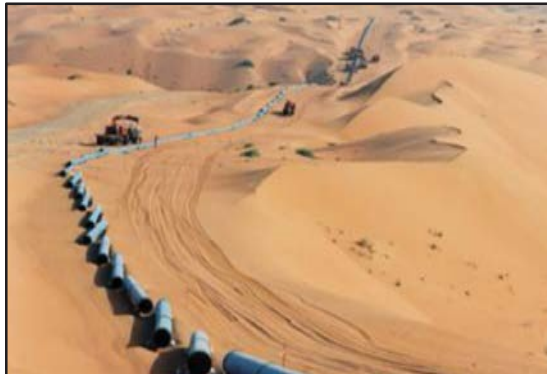
Tubería antes de soldar.
