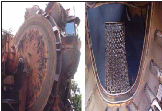
Tiempo de vida reparación con soldadura, 6 meses.
