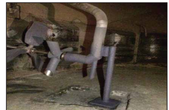
Diseño fue modificado para incluir soporte adicional a los mezcladores y lanzas.
