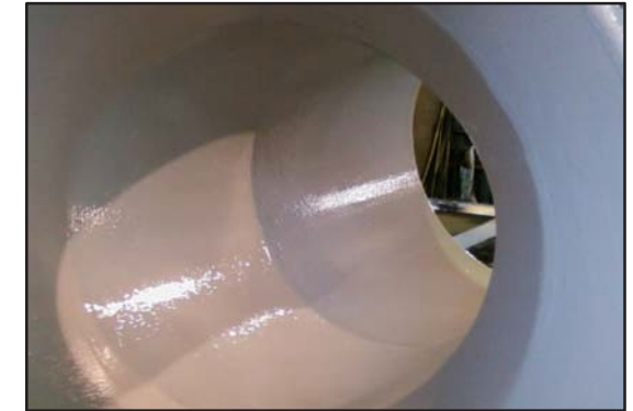
Sección de tubería terminada con ARC S7 .
