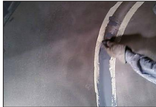
Aplicación de ARC 858 a los cordones de soldadura.
