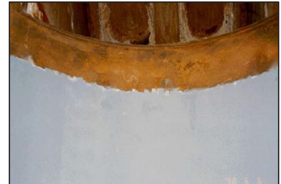
Segunda capa de ARC S7 aplicada.
