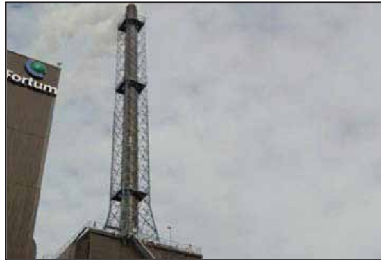
La chimenea de los gases de combustión en la central eléctrica.
