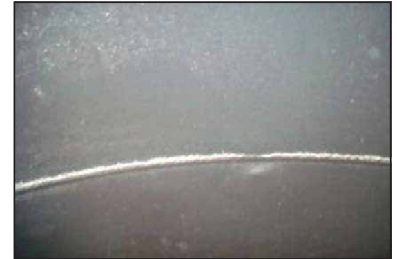
Revestimiento ARC S7 todavía en excelentes condiciones después de 10 años de servicio.
