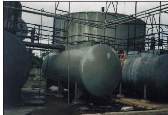
Tanques nuevos recubiertos con ARC S4+ internamente y ARC S2 externamente.
