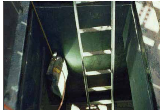
ARC Especificado por el ingeniero de planta.
