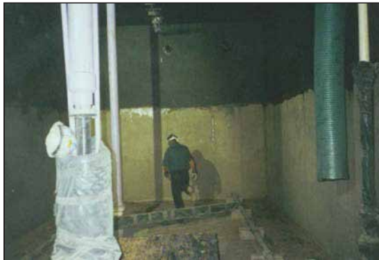
Concreto protegido con ARC 791 y ARC 988.
