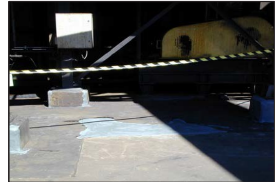
Superficies recubiertas con ARC presentaron reparaciones mínimas en el 2010.
