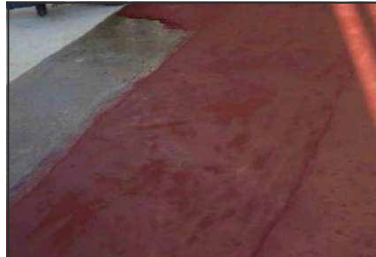
ARC 988 se aplica con llana.
