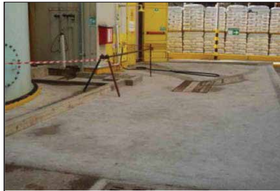
Losa de hormigón siguiente después de preparación de la superficie.
