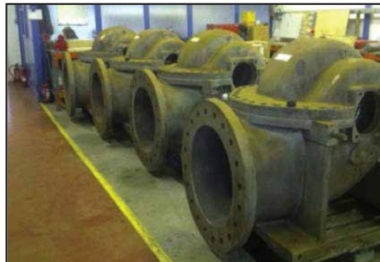
Bombas granalladas a la espera de recubrimiento.
