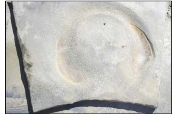
Placa anti desgaste recubierto con ARC BX1 después de 30 días.
