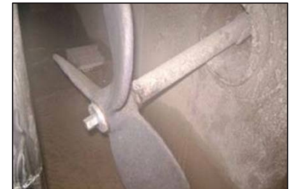
Agitador terminado instalado en el tanque.
