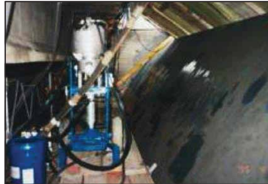
Reparación de picadura usando ARC 858.
