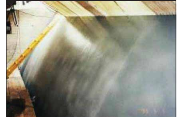
Compuerta recubierta con dos capas de ARC S2.
