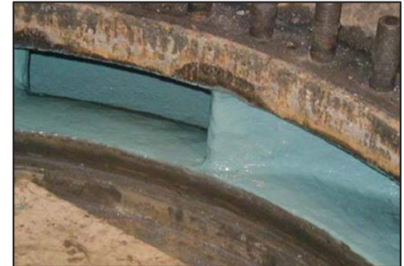
Dos capas de acabado con ARC S2 .
