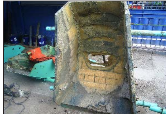
Chute revestido de cerámica después de 1500 horas.
