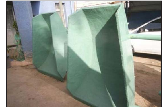
Chute revestido con ARC BX1* y capa final de ARC S2 .
