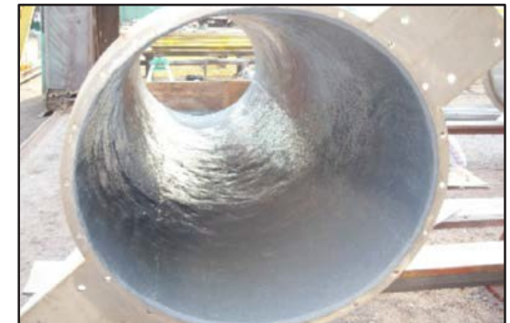
Sección del ducto de escoria terminado.
