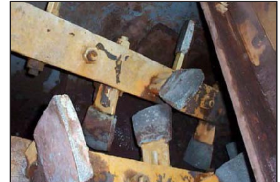
Paletas en servicio protegidas con revestimientos ARC .
