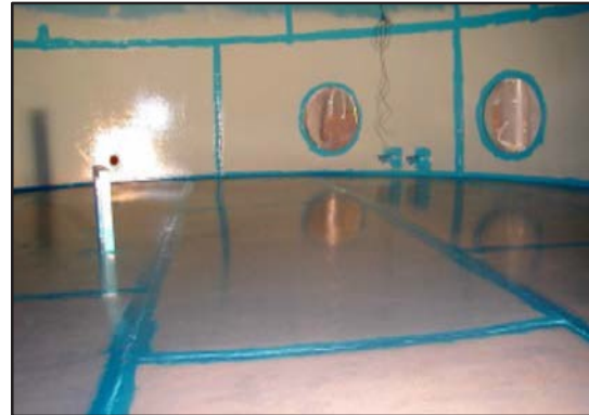
Capas de refuerzo en los cordones de soldadura entre la primera y la segunda capa con ARC S1 .
