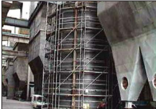
Vista exterior de uno de los tanques.
