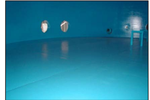
Vista de la capa finalizada.
