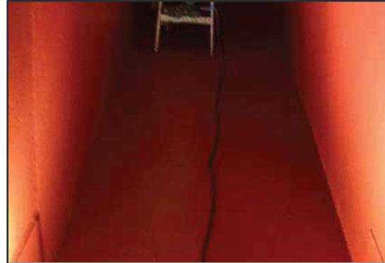
ARC S7 se aplica en los ductos utilizando equipo de pulverización sin aire.
