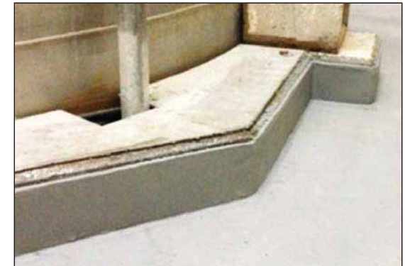
Vista de sección de recubrimiento final al piso.
