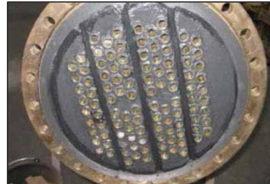
Placa de tubos terminada.
