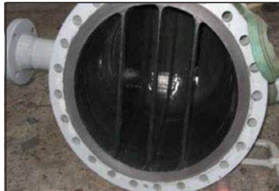
Placas divisoras reparadas.
