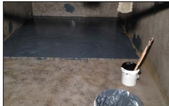
Aplicación de ARC 858 para recuperar y nivelar la superficie con socavaciones.
