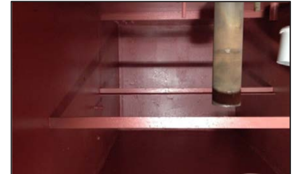
Interior del tanque recubierto.
